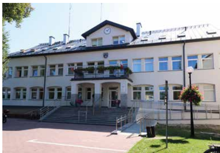
Urząd gminy po rewitalizacji
