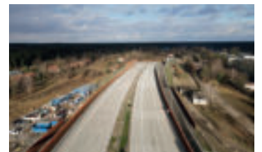
Koniec S17 w Zakręcie. Fot. GDDKiA
